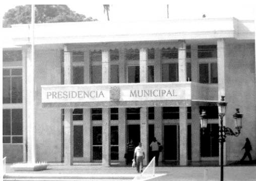
La antigua presidencia se demolió para construir un nuevo edificio. Ahí se montó el mural. Foto: Archivo Municipal de Torreón.
